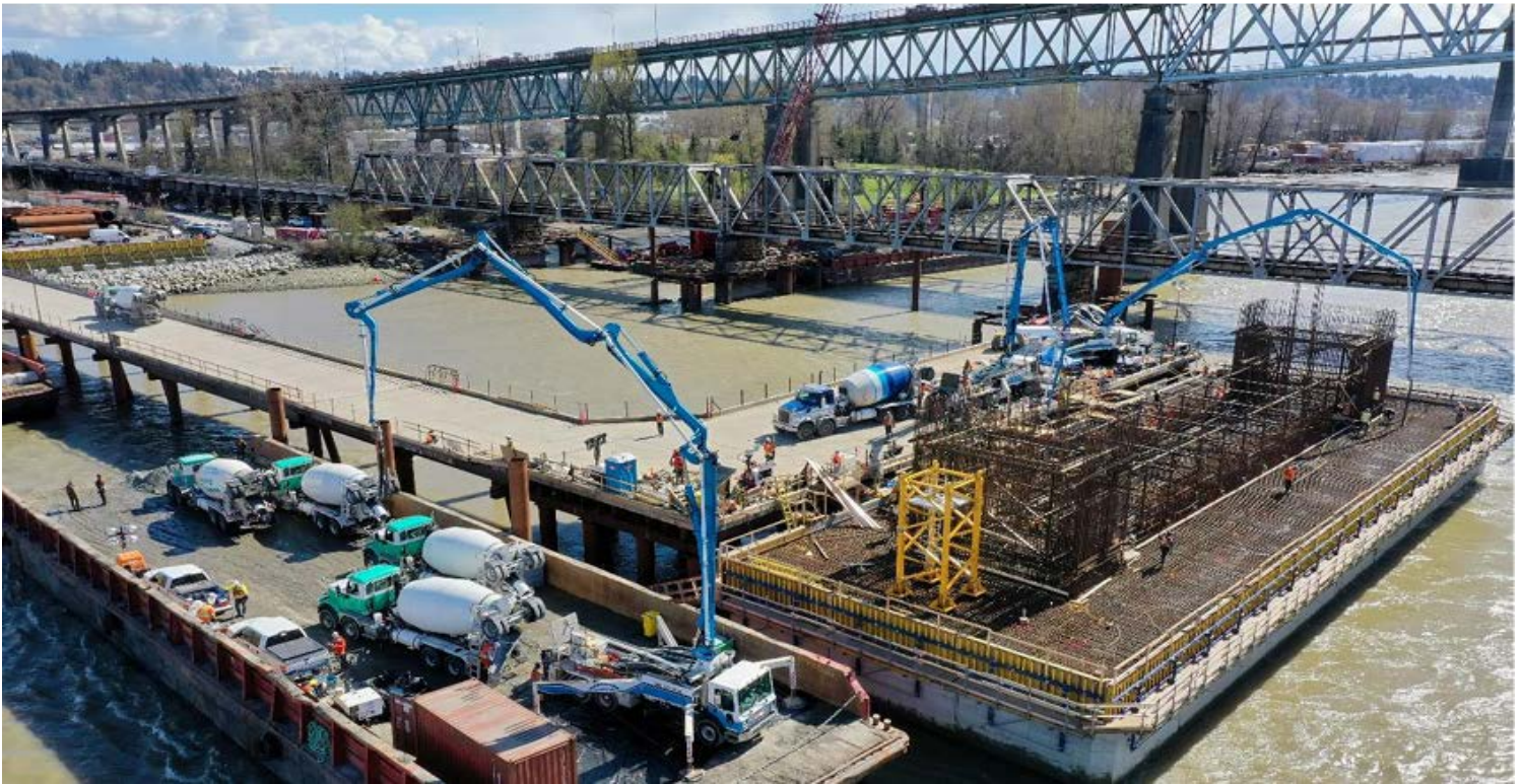
FIGURE 1 – PIER S1 BRIDGE FOUNDATION – PILE CAP CONCRETE POUR
